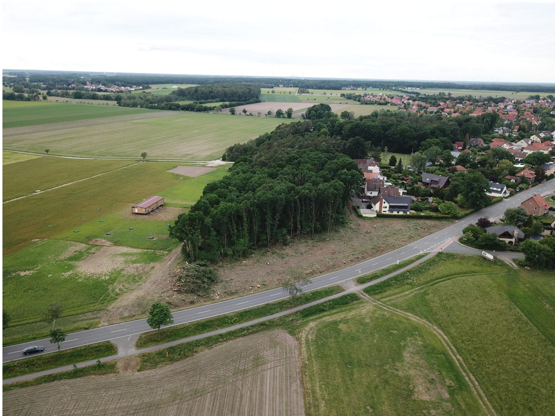
Blick auf die Fläche ( Luftbild, aus Richtung Süden )
